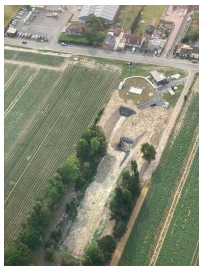
VUE AÉRIENNE DES TRAVAUX DES BASSINS
