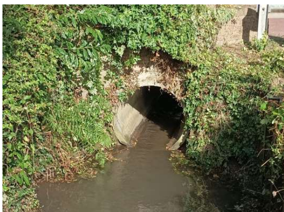
Pose d'une buse : soumis à la loi sur l'eau
