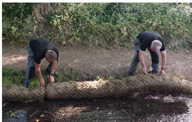
Réfection de berge en génie végétal : non soumis à la loi sur l'eau
