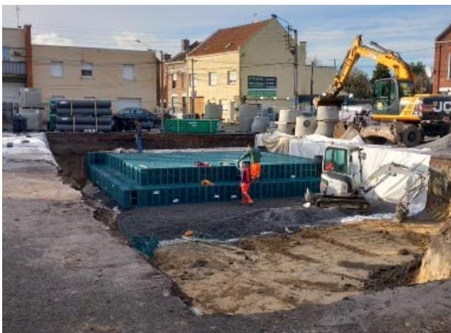
Réalisation d'un bassin d'infiltration d'un volume utile de 278 m<sup>3</sup> sur la place Charles Mathieu
