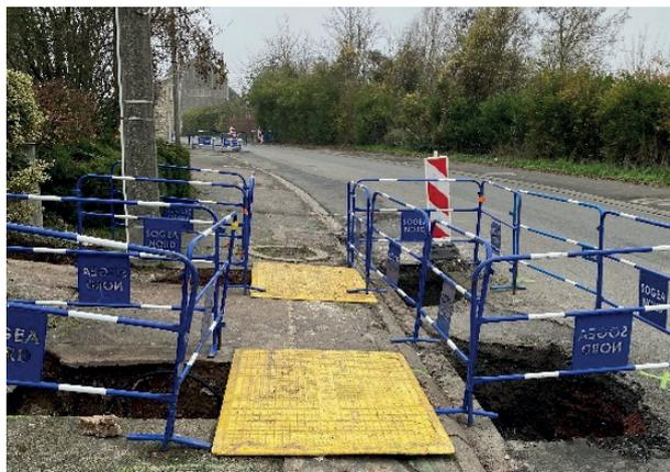
**Méricourt Cité des Cheminots :** Poursuite et fin en 2022 des travaux de renouvellement du réseau eau potable en fonte D200 sur 700 ml, en fonte D150 sur 365 ml et en PEHD sur D63 sur 80 ml avec la reprise des 194 branchements des habitations pour un montant de travaux 2022 de 62 286 € HT
